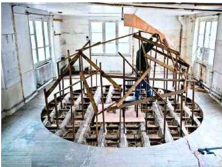
Bains Douches, 7, rue du Bourg-l'Abbé (III e ). La construction en bois réalisée par l'artiste Sambre n'est pas encore achevée. (Stephane Bisseuil)
