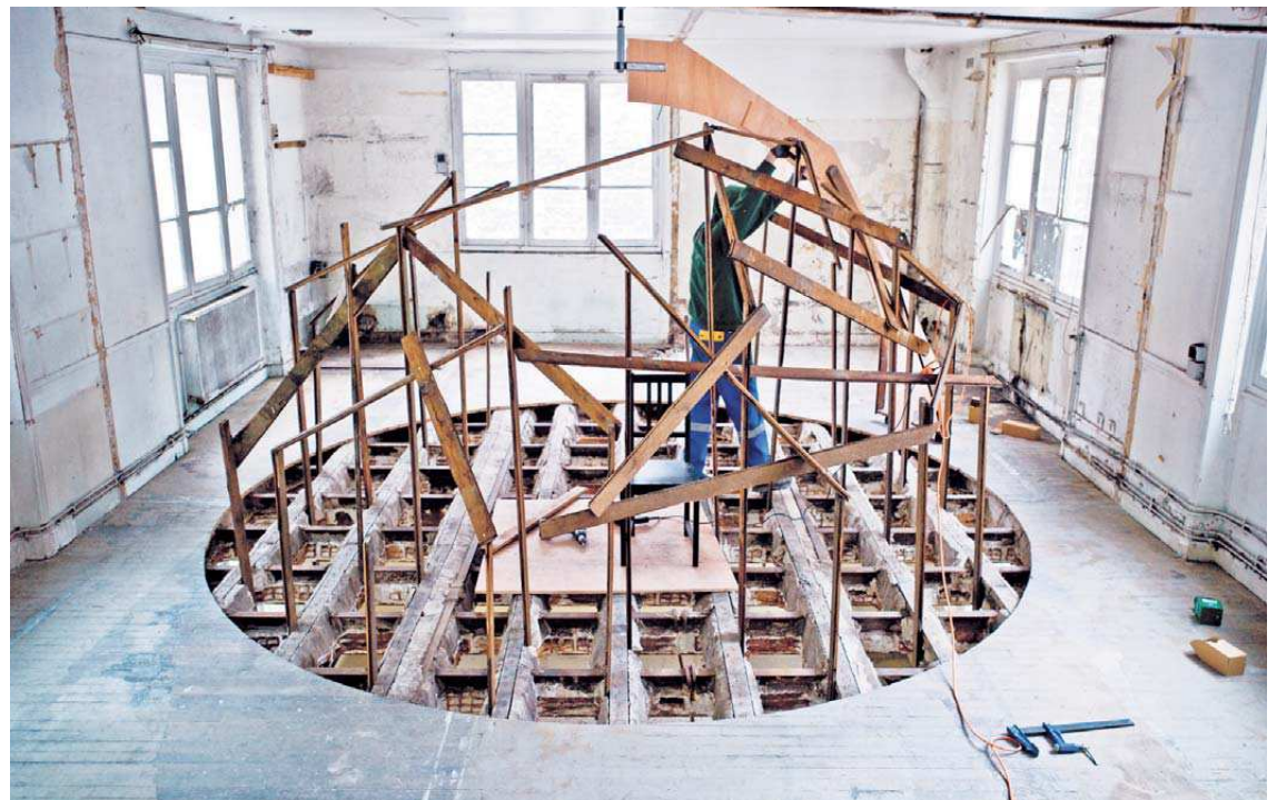
La sphère en bois de 4,40 mètres de diamètre imaginée par Sambre, encore en construction. Un clin d'œil à la boule à facettes et au passé du club. © Sambre/Photo Stéphane Bisseuil, courtesy Magda Danysz Gallery
